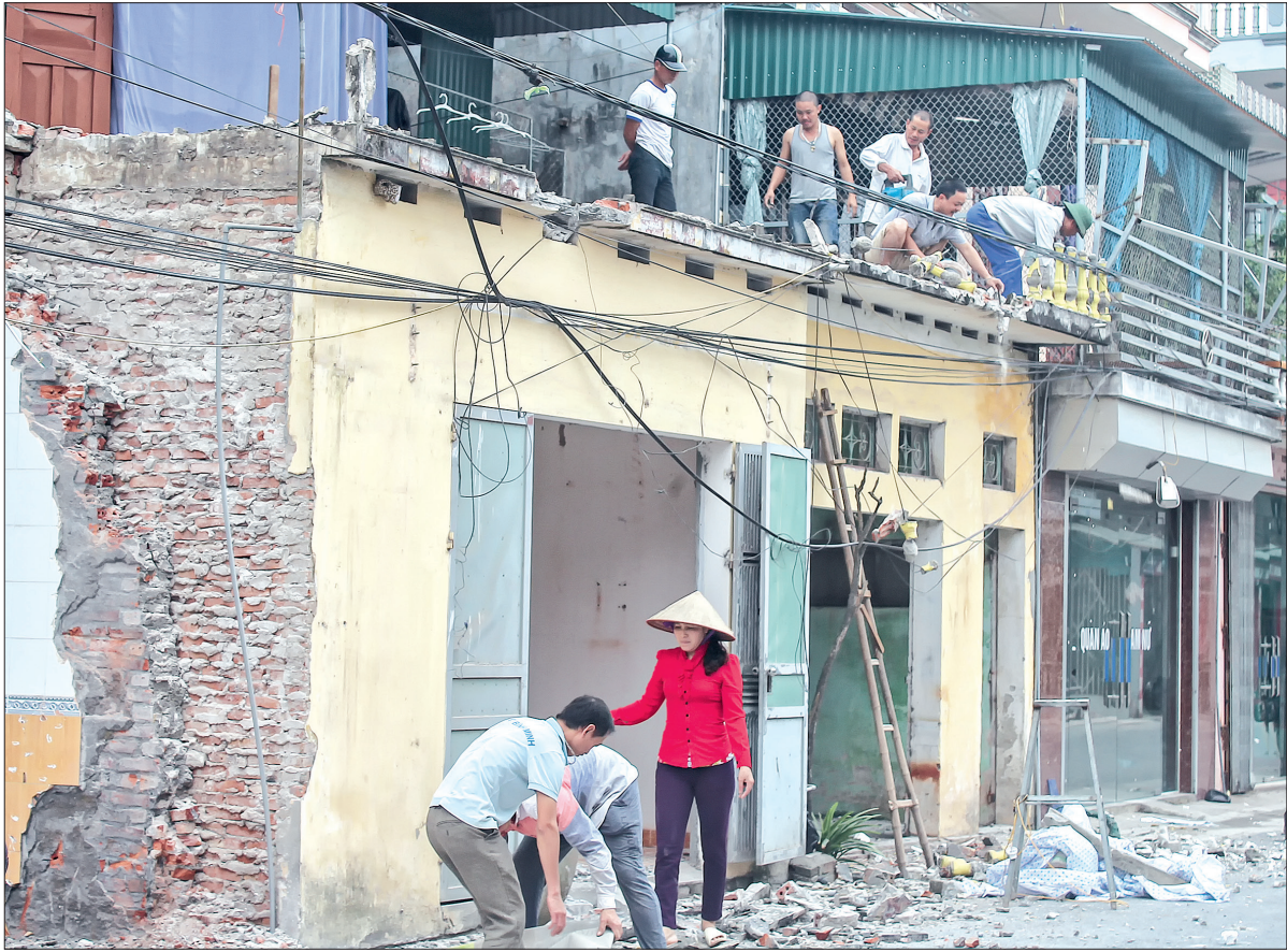
Các hộ dân tổ 10 thị trấn Đông Hưng tự giác tháo dỡ công trình vi phạm.
