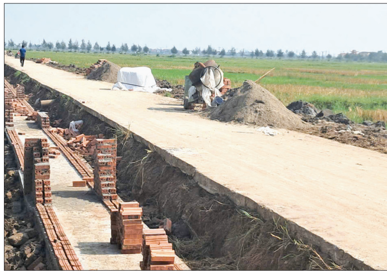
Xã Thụy Thanh huy động sức dân đầu tư xây dựng cơ sở hạ tầng.
