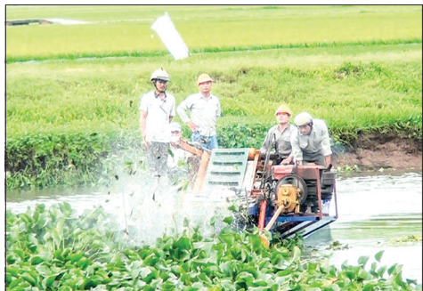
Khởi thông dòng chảy sông Cổ Rống, đoạn qua địa phận xã Tây Giang.
