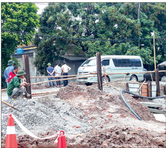
Đường 39 đoạn qua huyện Hưng Hà đang được đẩy nhanh tiến độ thi công.
