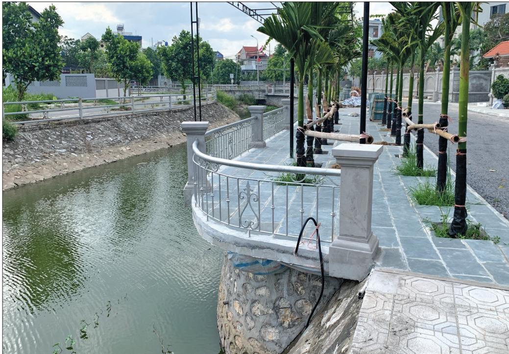
Gia đình ông Phạm Tiến Văn tự ý xây, cải tạo bờ kè lấn ra sông khiến lòng sông bị thu hẹp.
