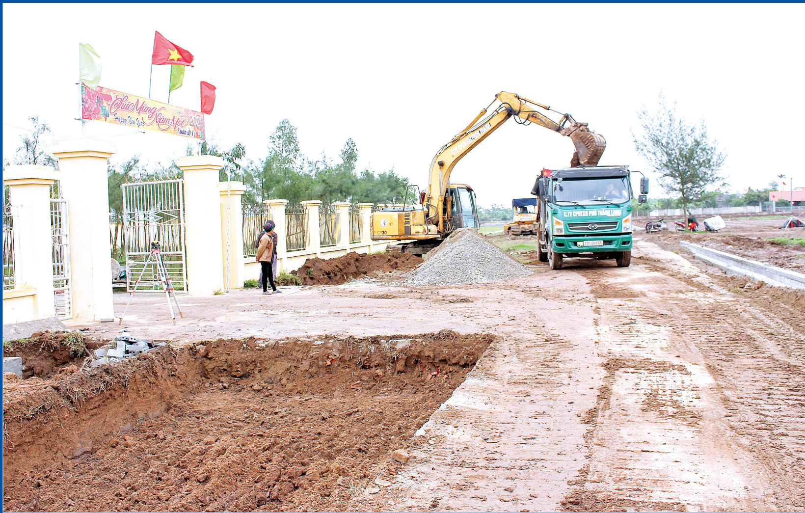
Xã Đông Quang triển khai xây dựng hạ tầng giao thông, khu dân cư để sớm đạt chuẩn nông thôn mới nâng cao.
