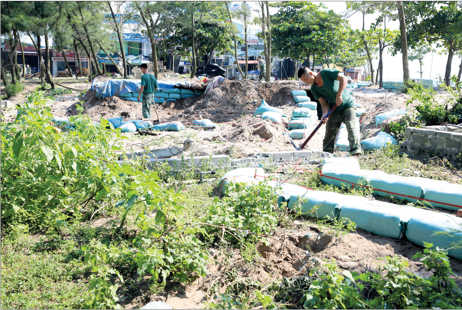
Cán bộ, chiến sĩ Trung đoàn 8, Sư đoàn 395 (Quân khu 3) tham gia xây dựng trận địa phục vụ diễn tập khu vực phòng thủ tỉnh năm 2019.
