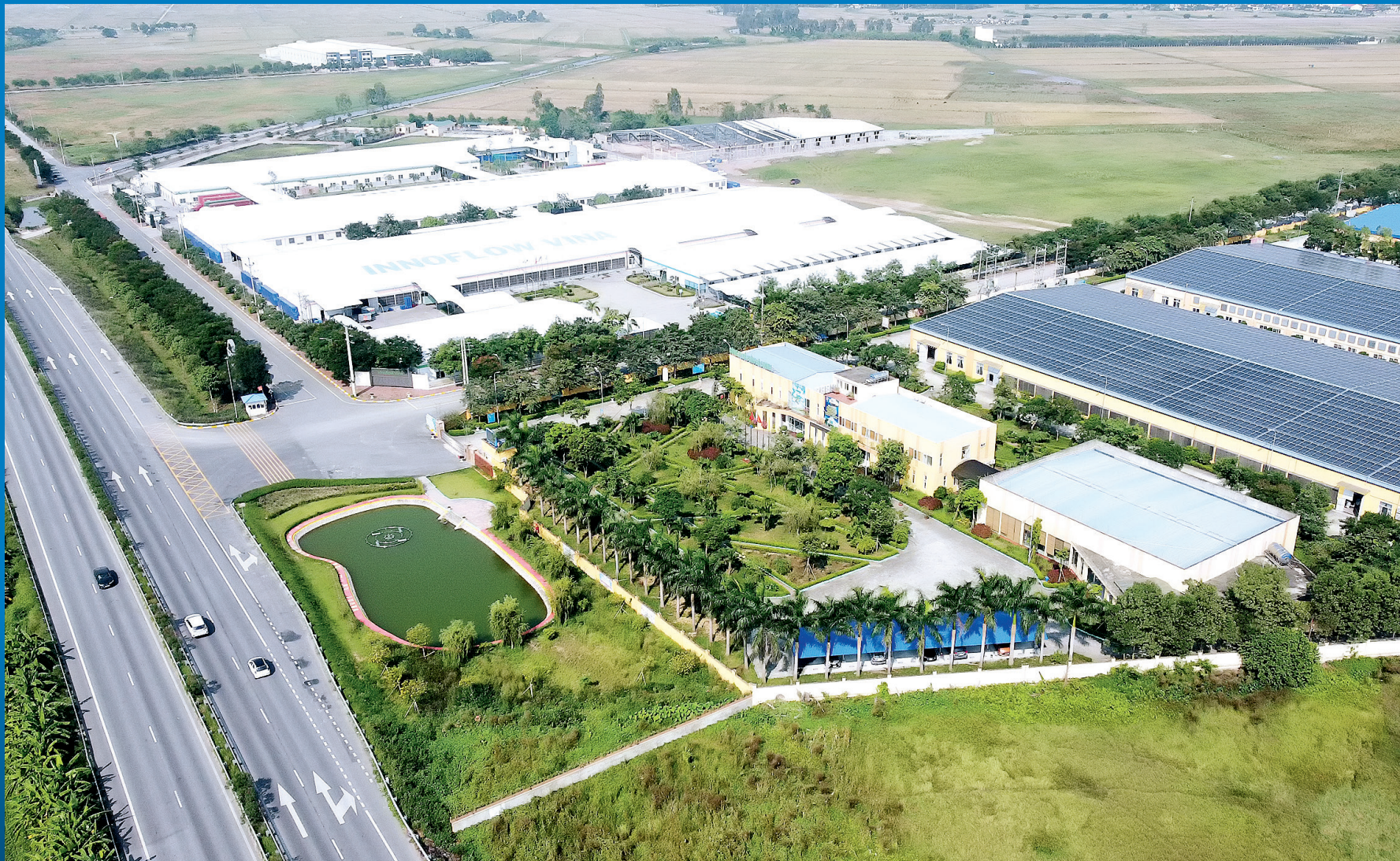
Cụm công nghiệp Đô Lương, huyện Đông Hưng.
