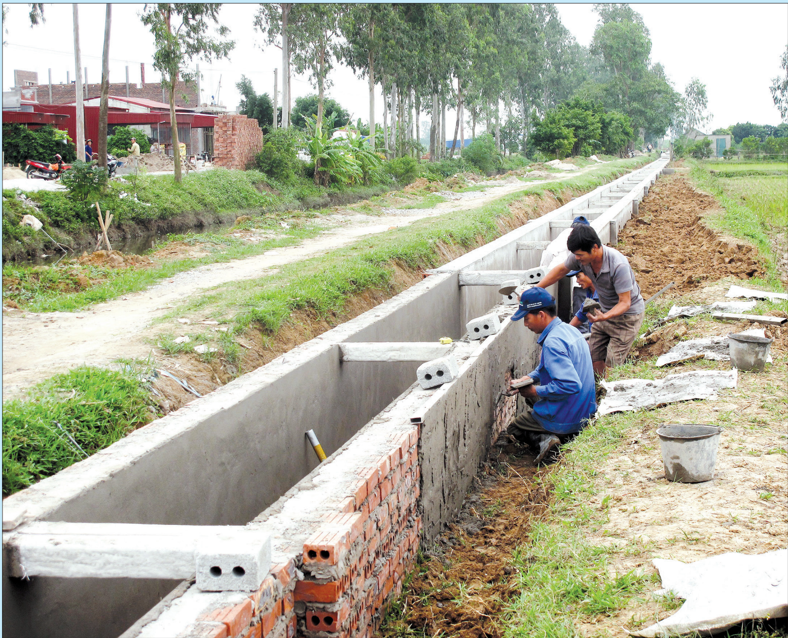
Cống hóa kênh mương ở xã Chí Hòa (Hưng Hà).
