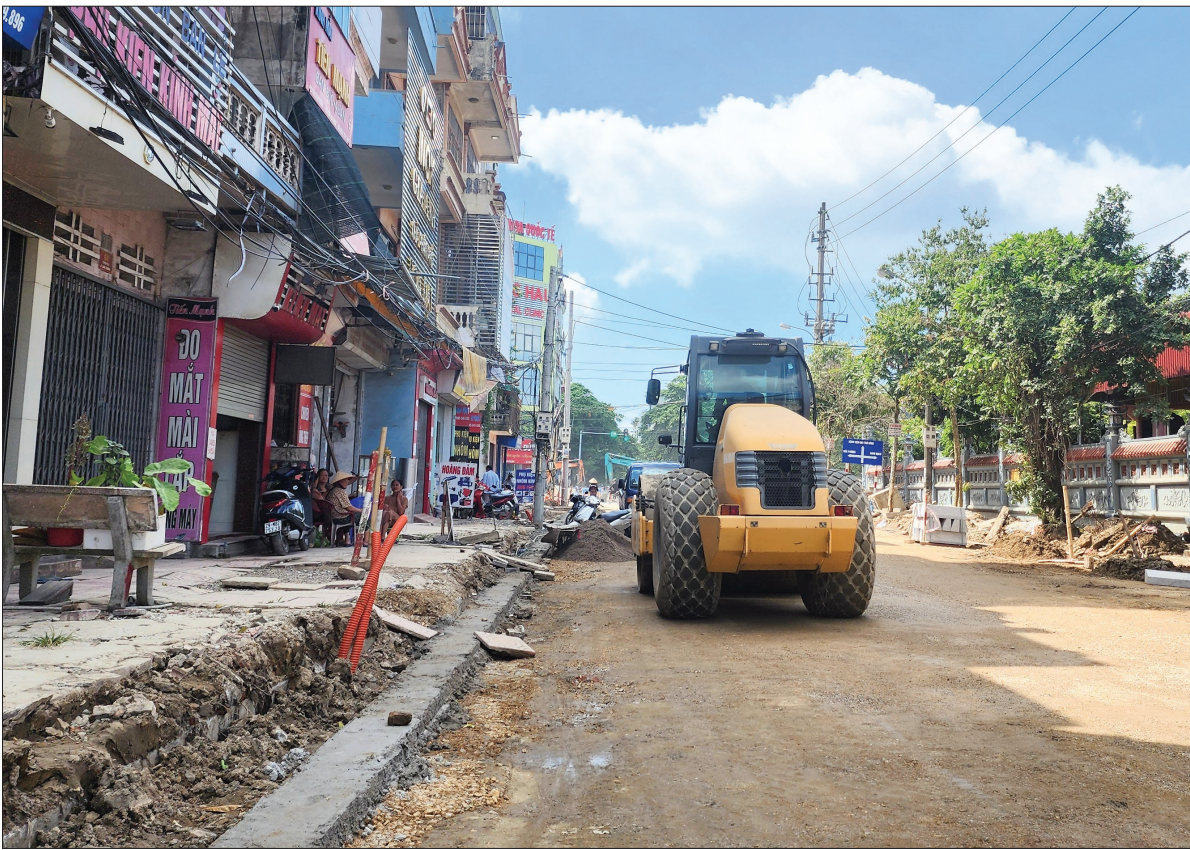
Thi công đường Lê Quý Đôn, đoạn từ ngã ba Trần Thủ Độ đến ngã tư Trần Thái Tông.
