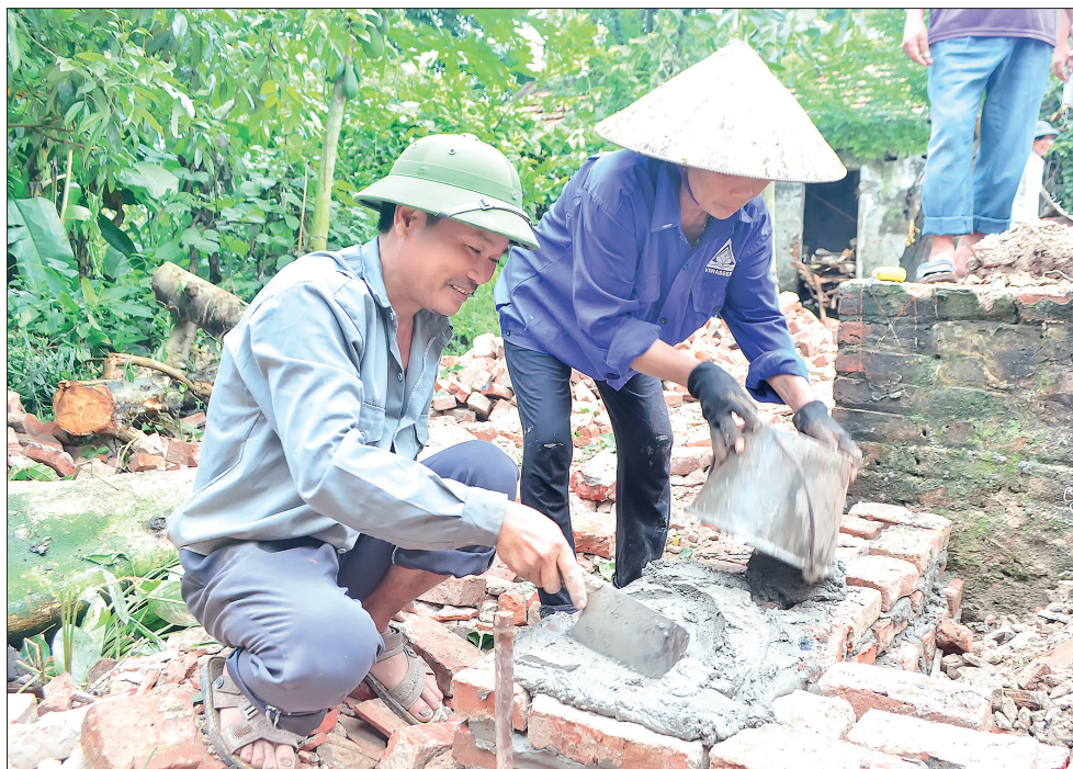
Xây nhà tình nghĩa cho cựu TNXP Trần Thị Tâm, thôn An Thái, xã Mê Linh (Đông Hưng).
