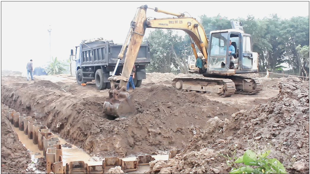
Thi công tuyến đường ĐH.89 đoạn qua địa bàn xã Thụy Liên.
