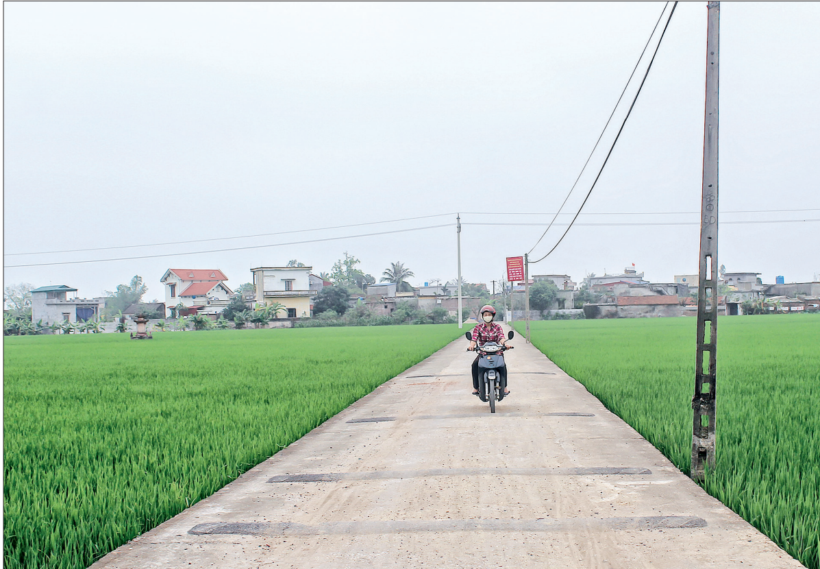
Đường giao thông nội đồng xã Hoa Lư (Đông Hưng) được bê tông hóa theo tiêu chí nông thôn mới.
