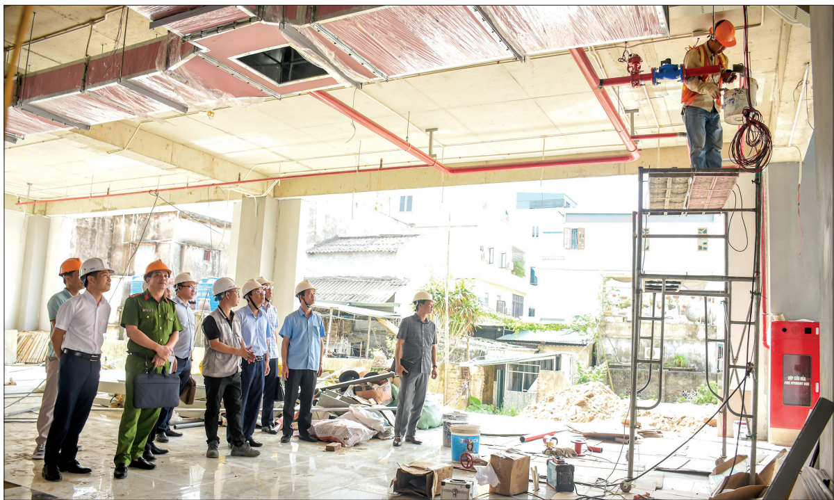
Cơ quan chức năng kiểm tra việc chấp hành các quy định của pháp luật về bảo đảm an toàn, vệ sinh lao động tại một công trình xây dựng trên địa bàn thành phố Thái Bình.
