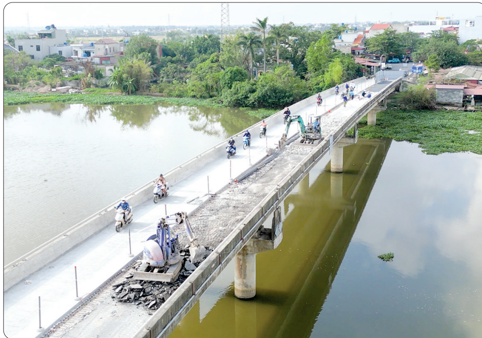
Năm 2024, Sở Giao thông Vận tải đã làm tốt công tác quản lý, bảo trì đường bộ. Trong ảnh: Duy tu, sửa chữa cầu Vô Hối nối hai huyện Đông Hưng - Thái Thụy.
