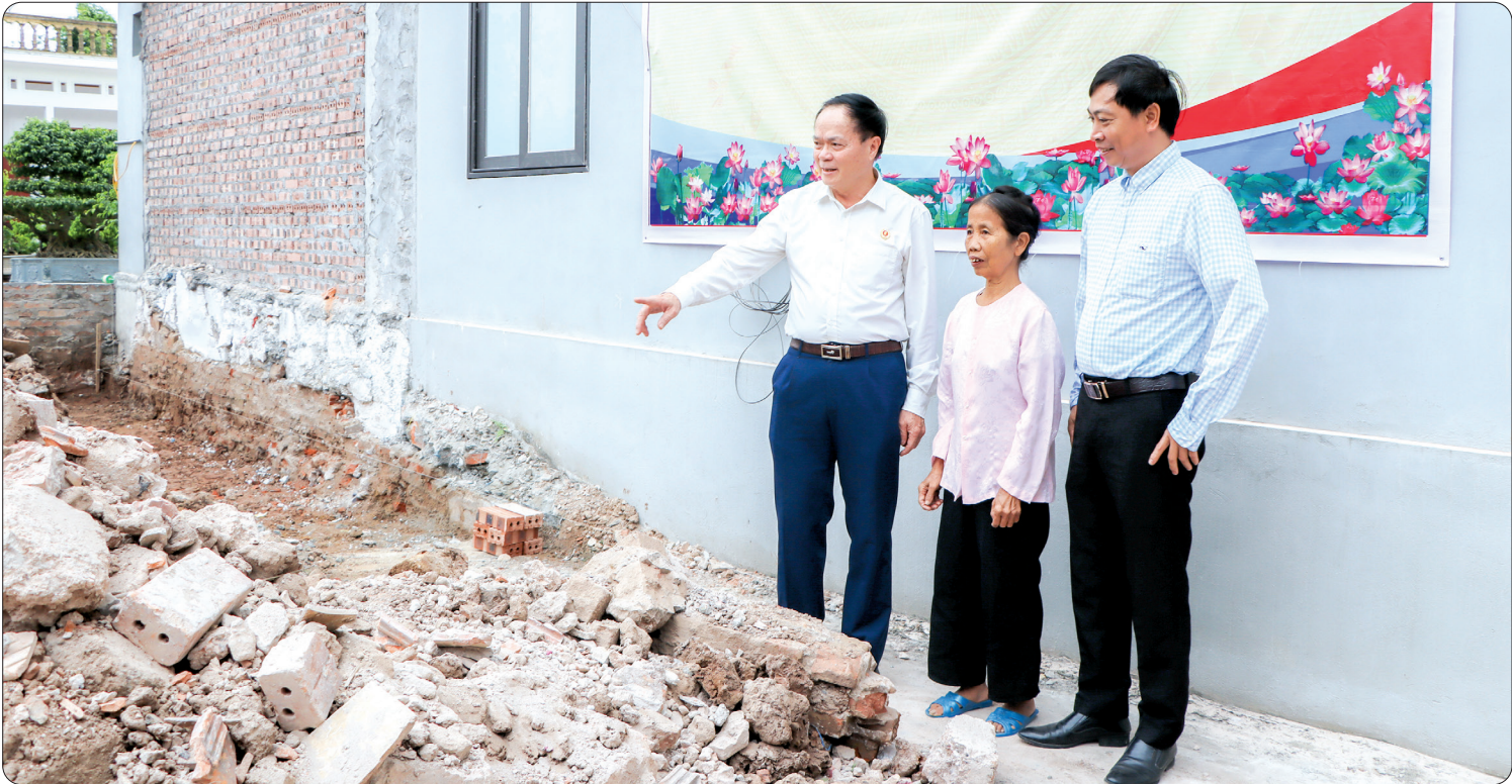
Khởi công xây nhà cho bà Nguyễn Thị Luyến, thôn Trà Vy Bắc, xã Vũ Công (Kiến Xương).
