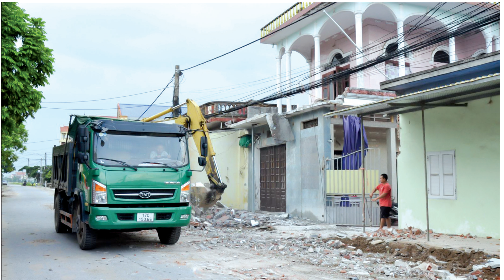
Giải phóng mặt bằng tuyến đường ĐH.61 đoạn qua địa phận xã Tân Hòa (Hưng Hà).
