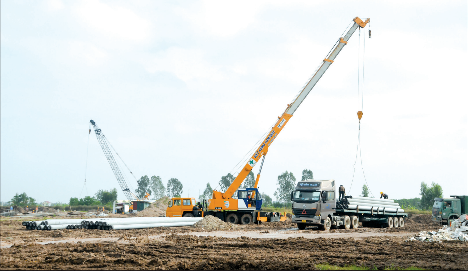
Cụm công nghiệp Quý Ninh (Quỳnh Phụ) đẩy nhanh tiến độ hoàn thiện hạ tầng để thu hút các nhà đầu tư.
