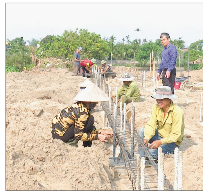
Thi công trụ sở UBND xã Thái Thịnh.
