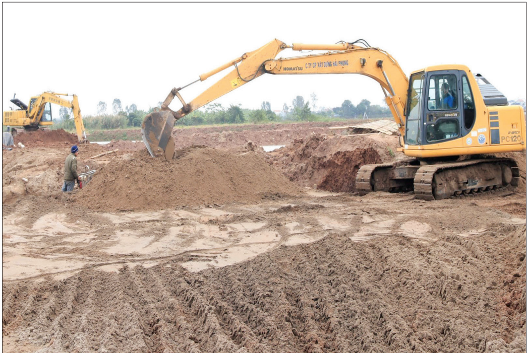
Huyện Hưng Hà đẩy nhanh tiến độ xây dựng hạ tầng các cụm công nghiệp để thu hút các nhà đầu tư thủ cấp.
