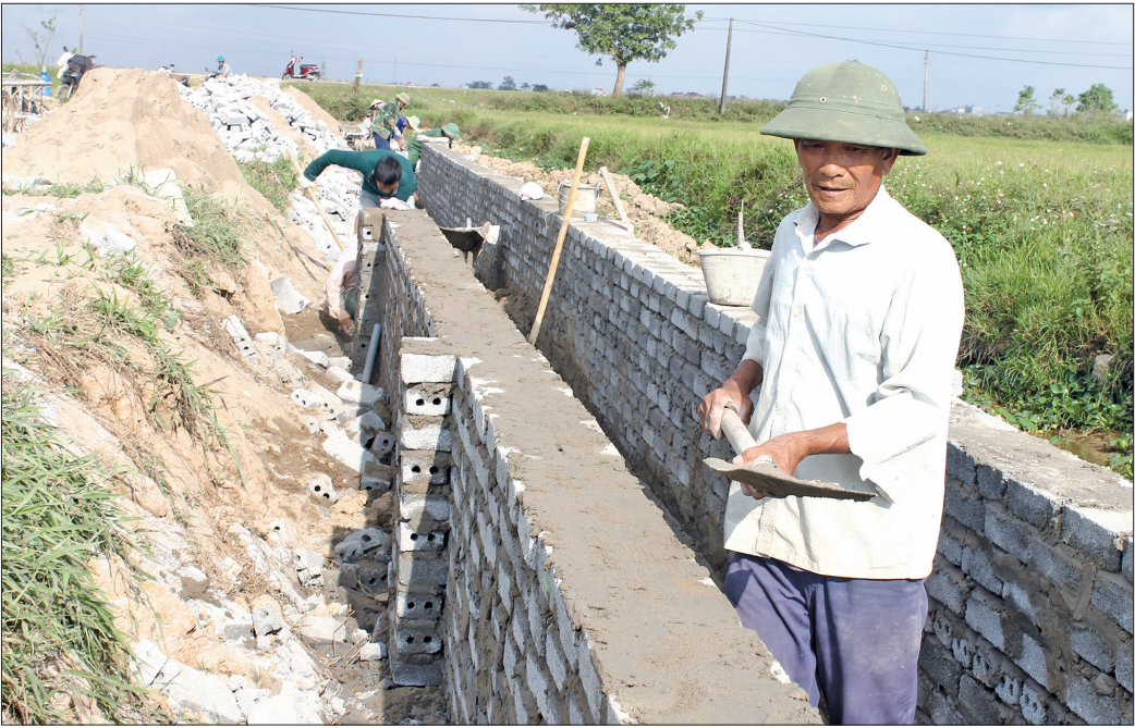
Xây dựng hệ thống thủy lợi nội đồng ở xã Dũng Nghĩa (Vũ Thư).
