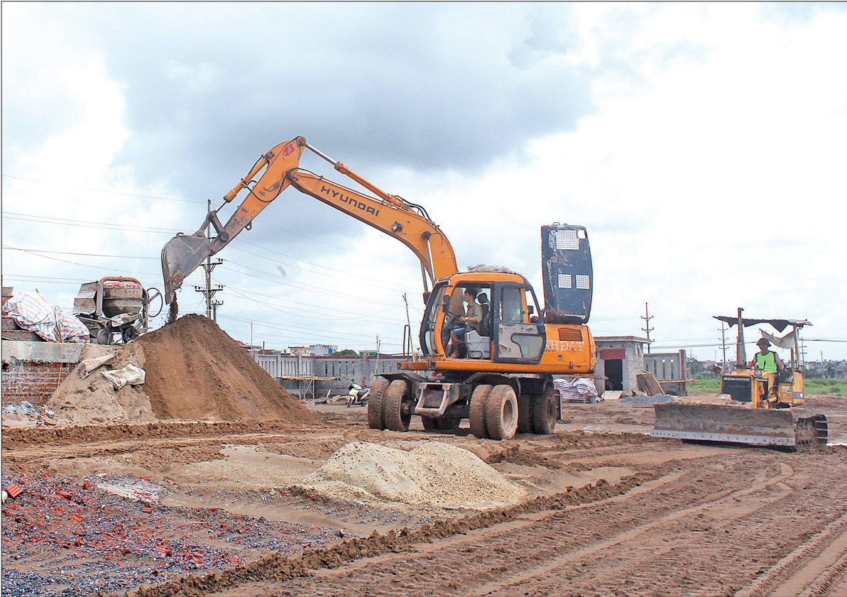
Công nhân Công ty Cổ phần Xây dựng Thành Đạt thi công công trình sân vận động huyện Đông Hưng.
