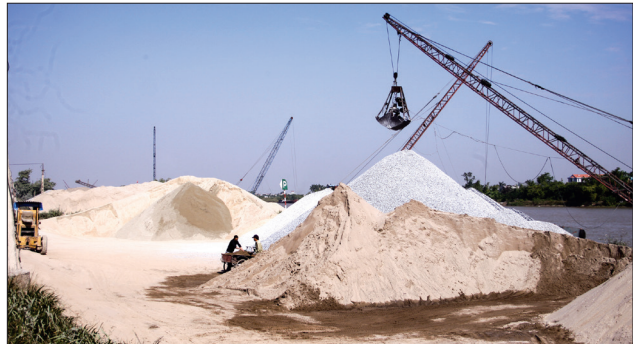
Bãi tập kết vật liệu xây dựng cạnh đê Trà Lý, đoạn qua địa phận phường Tiên Phong, thành phố Thái Bình.
