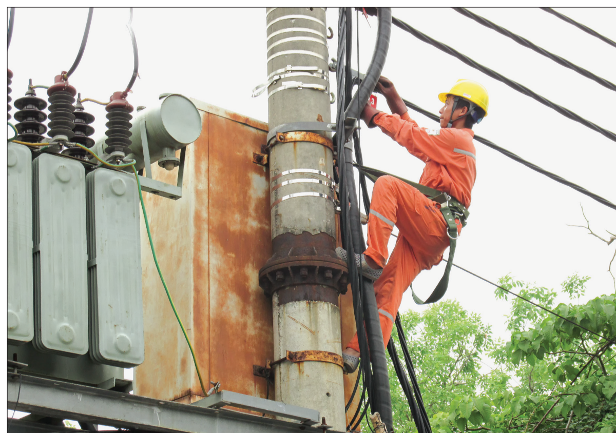
Công nhân Điện lực thành phố Thái Bình kiểm tra hệ thống trạm biến áp.
