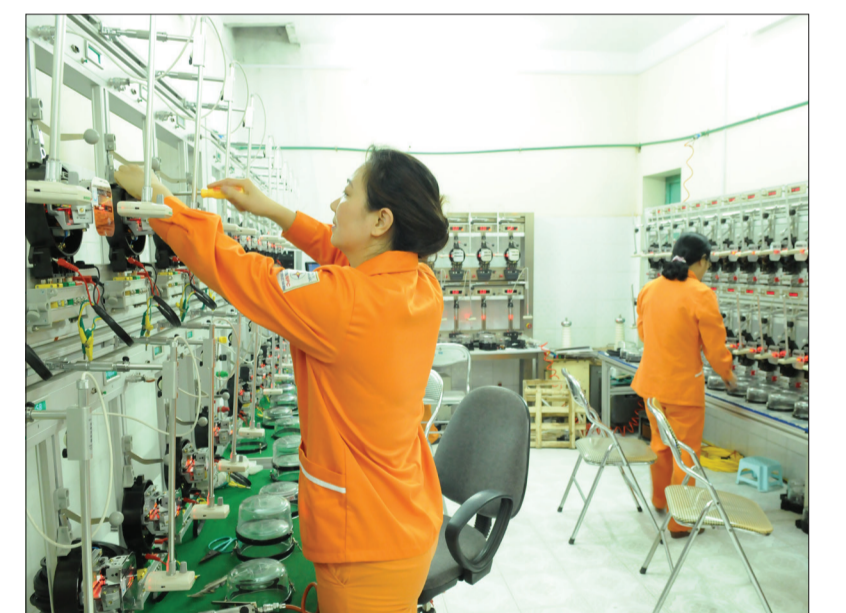
Công nhân điện lực kiểm tra, kiểm định thiết bị đo đếm điện. Ảnh: THANH TÂM
