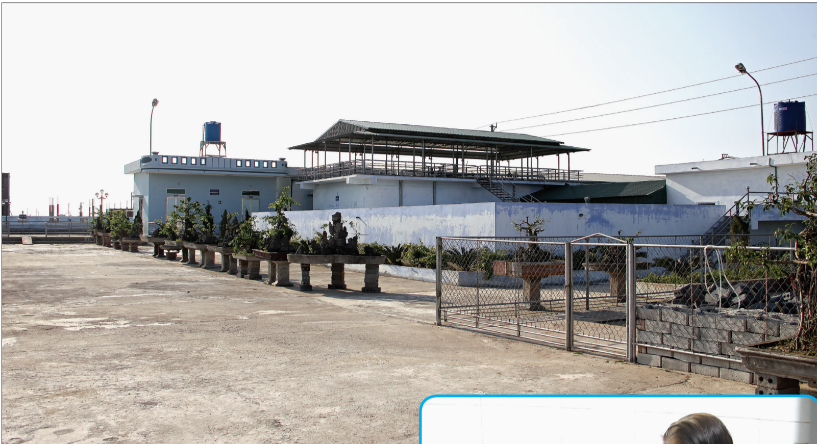
Nhà máy nước sạch do Công ty Cổ phần Phát triển Thủy Long xây dựng tại xã Vũ Quý (Kiến Xương).
