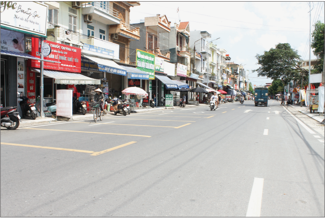
Nhờ sự đồng thuận của người dân trong công tác giải phóng mặt bằng, tuyến đường tỉnh 454 đoạn qua trụ sở UBND xã Vũ Hội (Vũ Thư) đã hoàn thành và đưa vào sử dụng, tạo diện mạo nông thôn mới khang trang.
