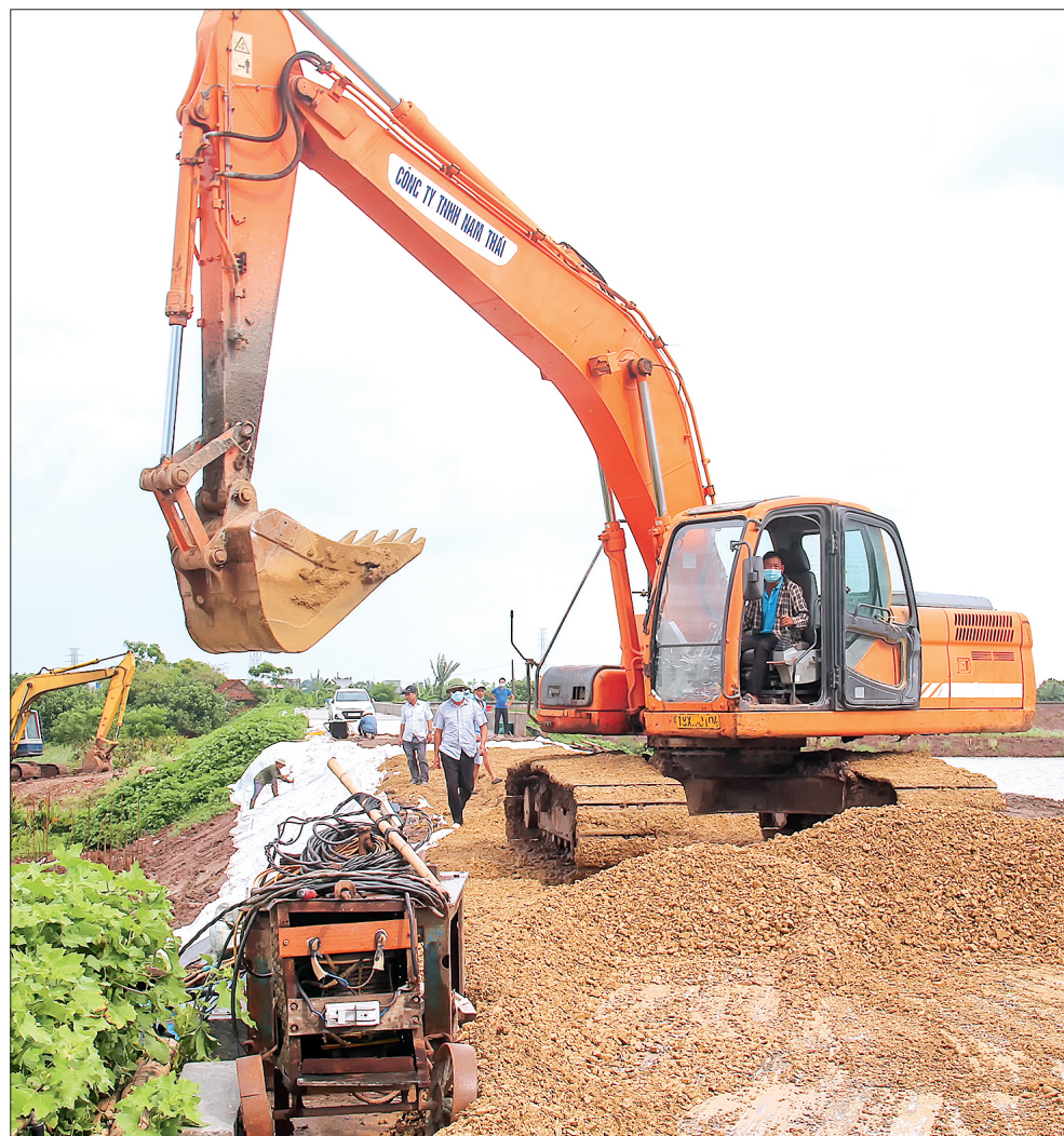
Đắp bêtông gia cố mặt đê biển số 6 (Thái Thụy).
