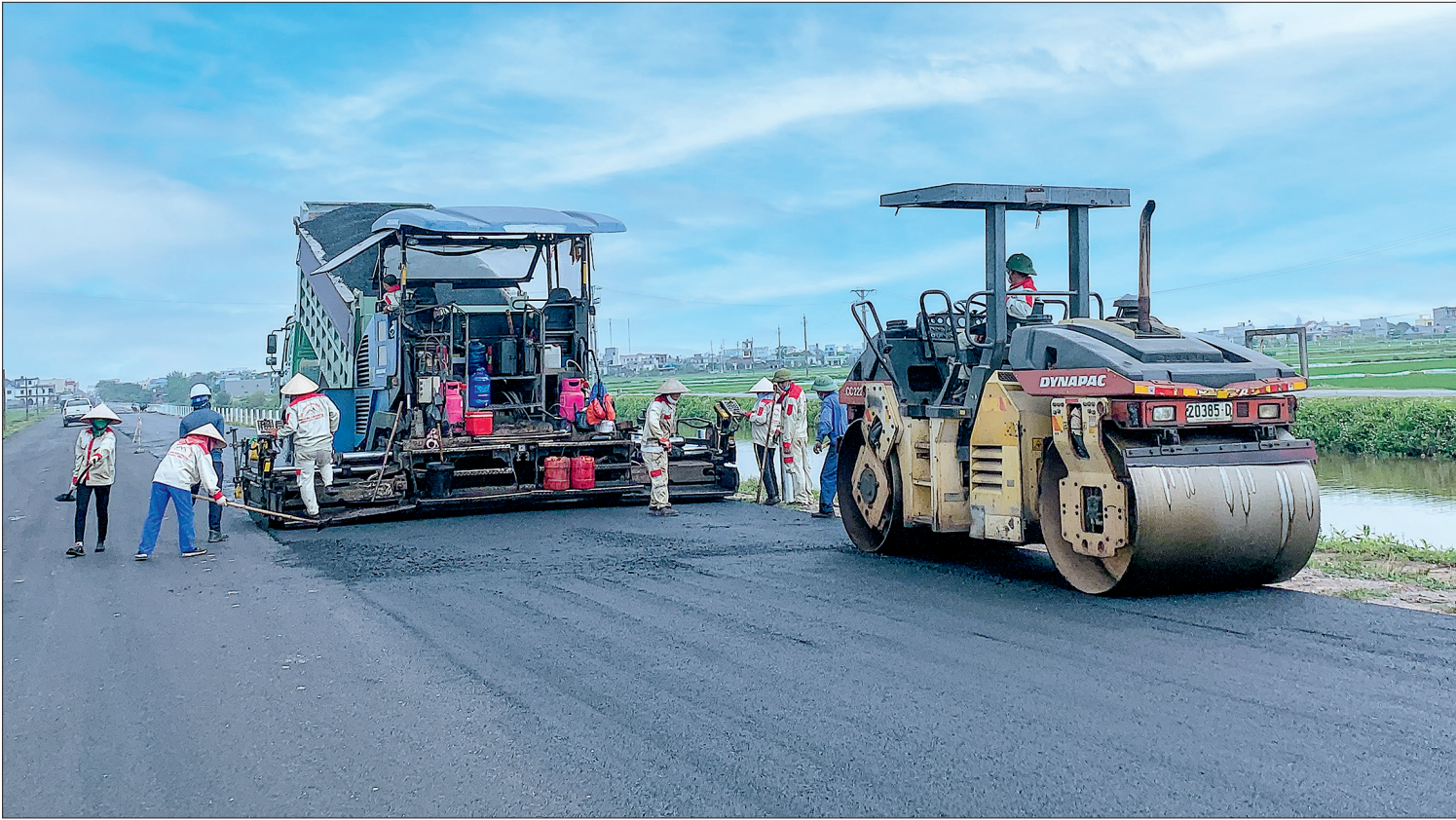
Đơn vị thi công tập trung nhân lực, máy móc hoàn thiện những hạng mục cuối.
