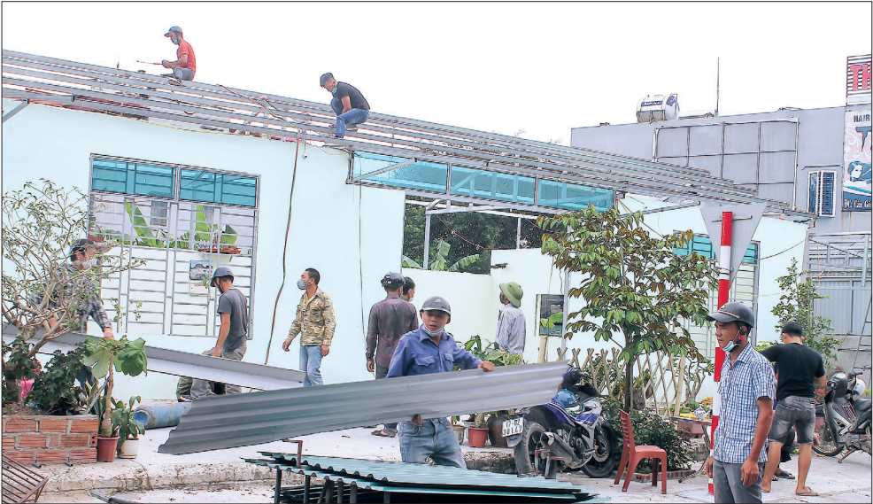
Một hộ dân tự nguyện tháo dỡ công trình xây dựng, đồng thuận thu hồi đất, giải phóng mặt bằng phục vụ dự án đầu tư xây dựng cụm công nghiệp Minh Lăng.
