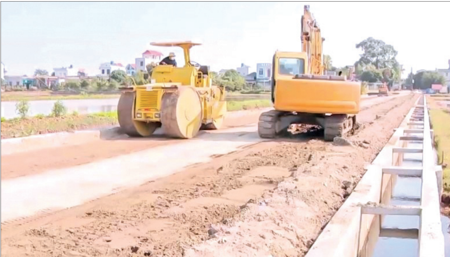
Nhà thầu tập trung máy móc, nhân lực đẩy nhanh tiến độ thi công đường ĐH.45 huyện Đông Hưng đến đường tỉnh ĐT.396B.
