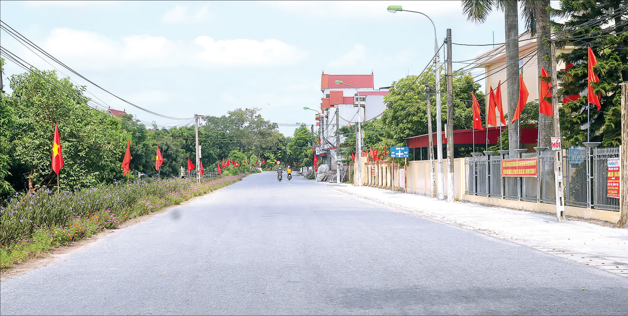
Đường giao thông xã Chí Hòa (Hưng Hà) được đầu tư xây dựng đáp ứng nhu cầu đi lại của nhân dân.
