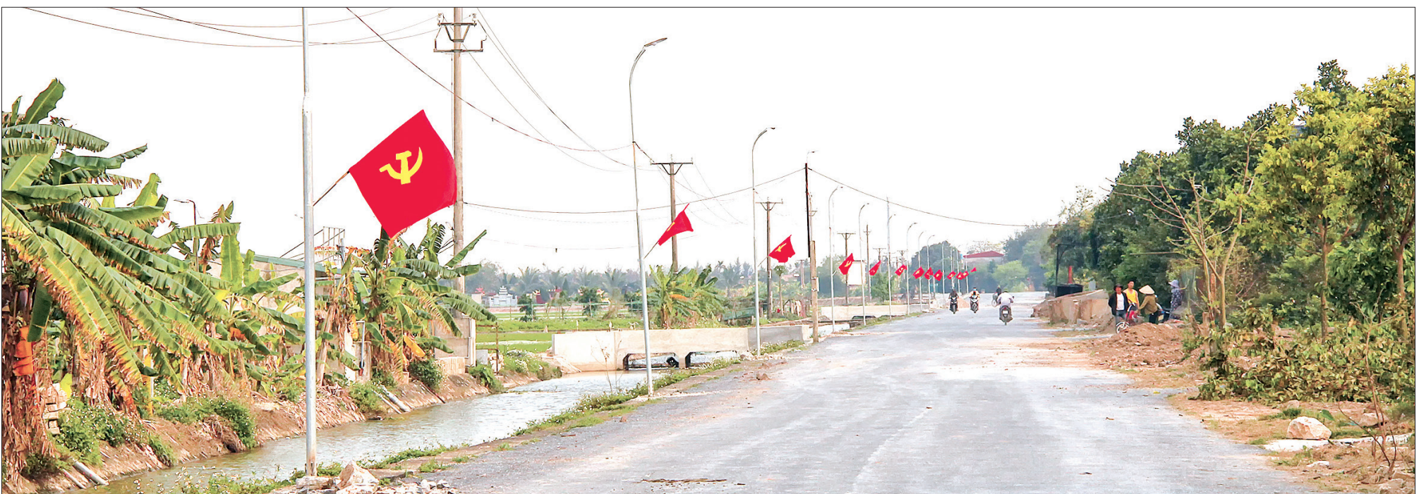
Đường cứu hộ, cứu nạn từ đê tả Trà Lý đến quốc lộ 39 thi công xong đến đâu, nhân dân lắp điện chiếu sáng, trồng cây xanh đến đó.
