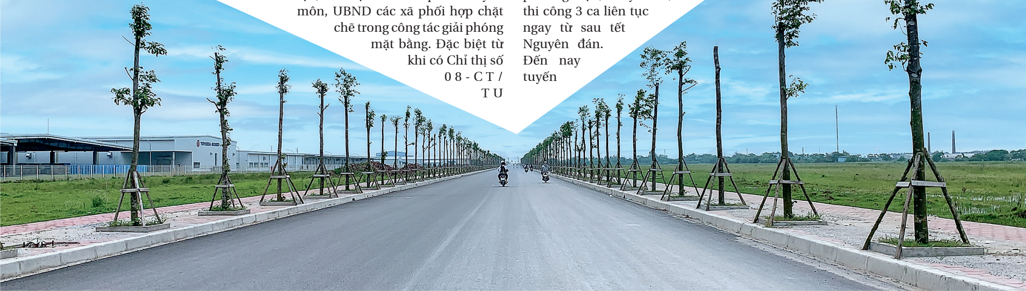
Tuyến đường 221A đã cơ bản hoàn thành.
