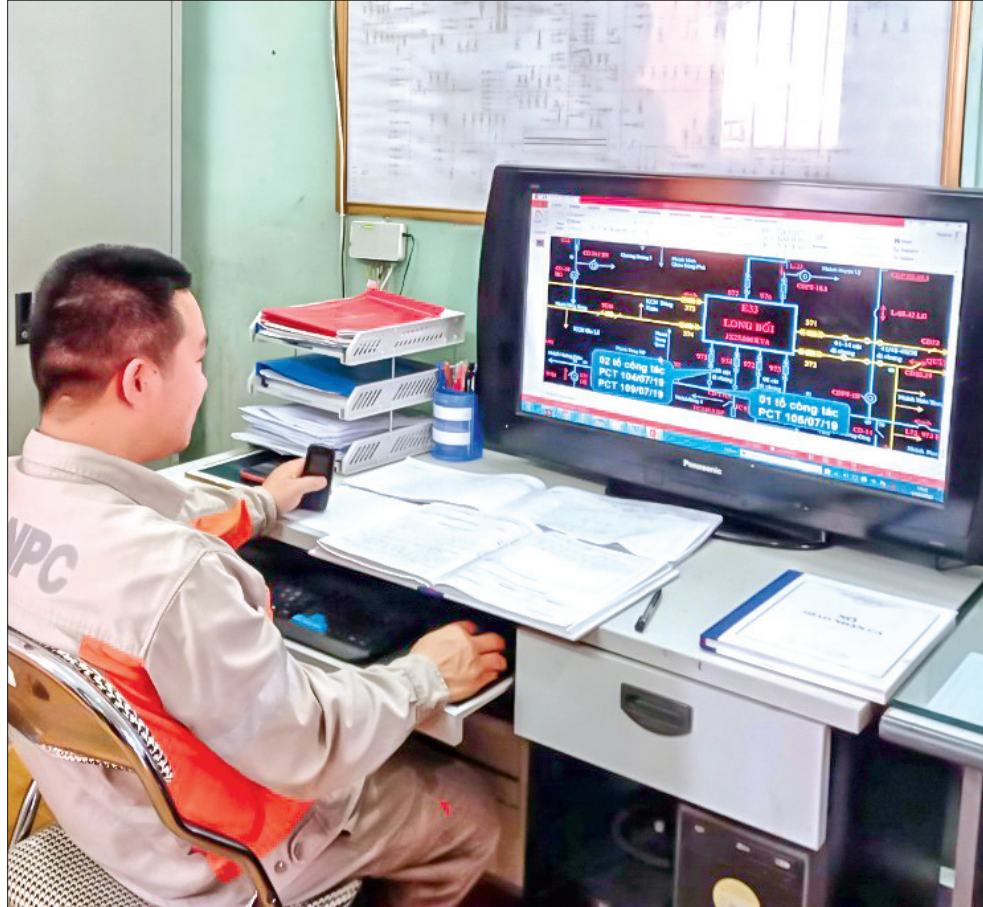
Điện lực Đông Hưng quản lý, vận hành hệ thống điện trên địa bàn huyện thông qua phần mềm chuyên dụng.
