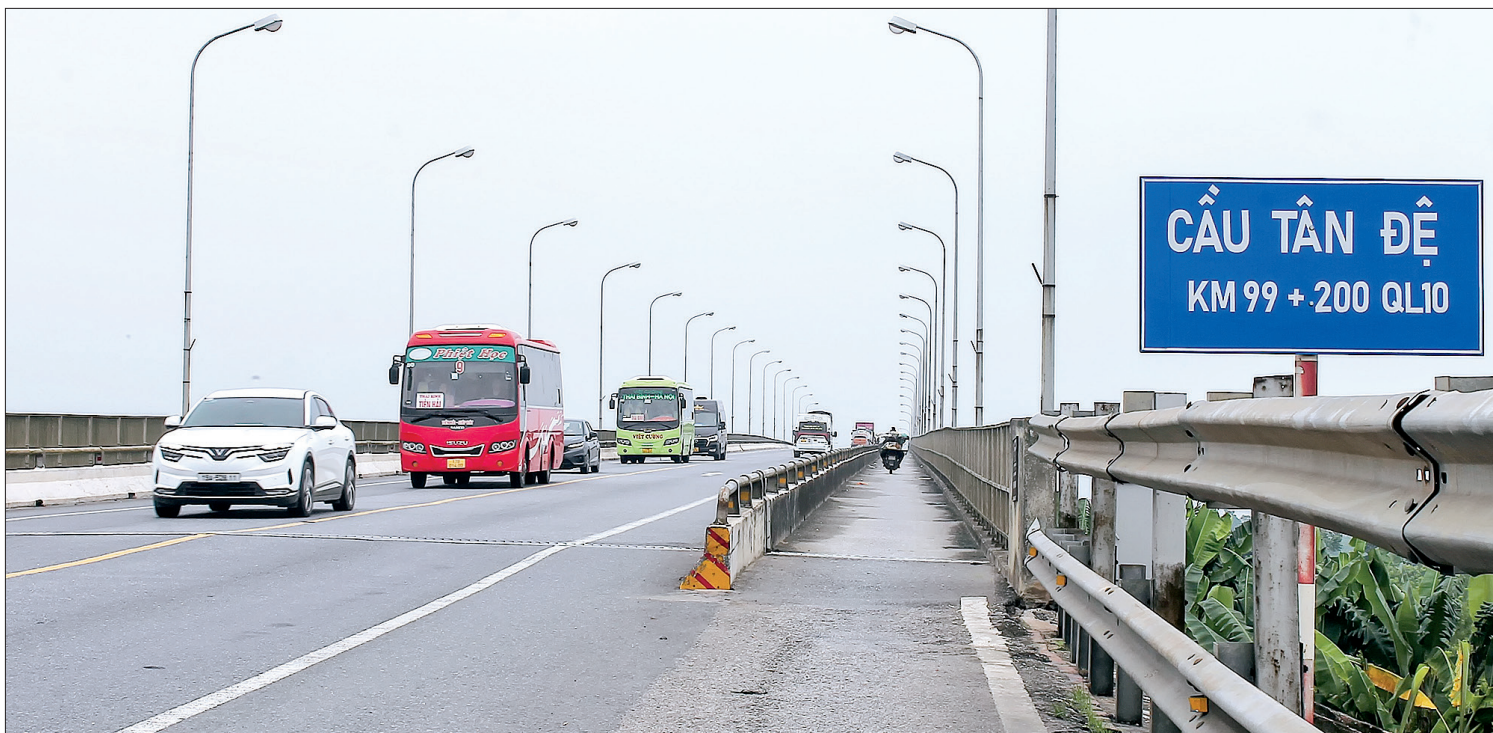
Cầu Tân Đệ được xây dựng đã thay thế cho bến phà Tân Đệ xưa.
