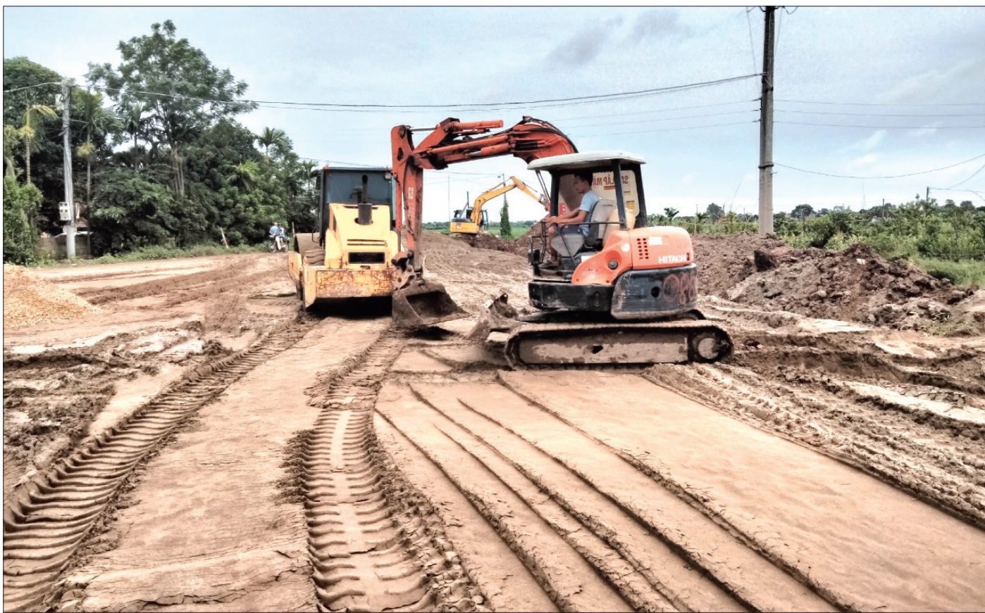
Được gia hạn thuế giúp Công ty TNHH Xây dựng và Kinh doanh Tuấn Anh (xã Quỳnh Giao, huyện Quỳnh Phụ) giảm bớt khó khăn về tài chính. Trong ảnh: Công ty TNHH Xây dựng và Kinh doanh Tuấn Anh thi công dự án cải tạo, nâng cấp đường tỉnh 452 (nay là đường tỉnh 452A) đoạn qua xã Quỳnh Mỹ (Quỳnh Phụ).
