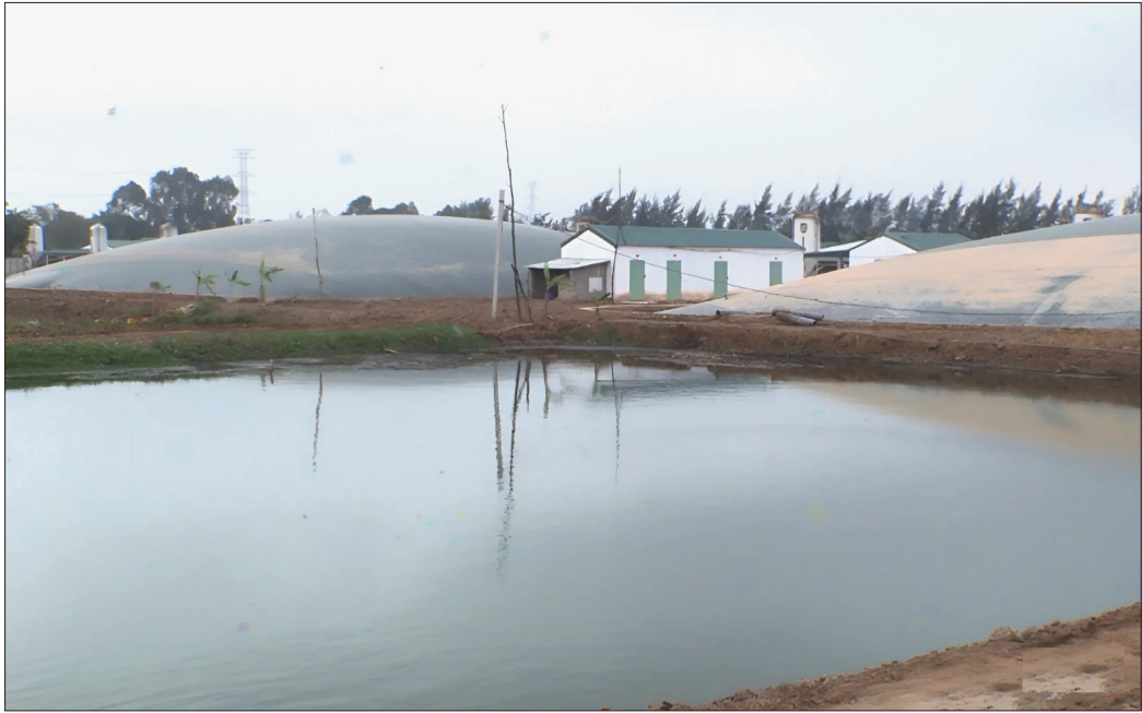
Mô hình xử lý chất thải chăn nuôi bằng bể biogas tại một trang trại thuộc xã Thụy Duyên (Thái Thụy).
