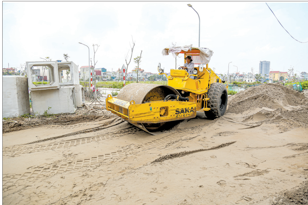
Các nhà thầu đang khẩn trương hoàn thiện tuyến đường thuộc tổ dân phố Hồ Đội 2, thị trấn Diêm Điền (Thái Thụy).
