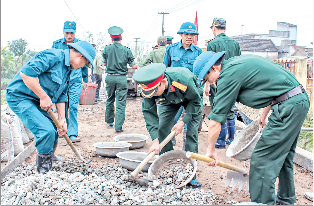
Lực lượng vũ trang tỉnh tham gia làm đường giao thông nông thôn tại huyện Quỳnh Phụ.
