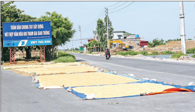
Đường tỉnh 456 đoạn qua xã Thụy Dương.
