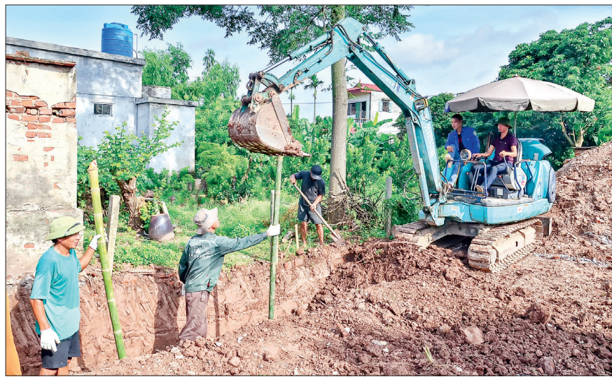
Khởi công xây dựng nhà tình nghĩa cho bà Phạm Thị Xuân (71 tuổi) ở xóm 18, xã Đông Hòa (thành phố Thái Bình).
