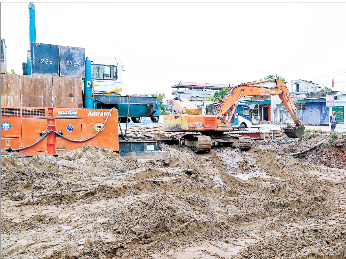
Cầu Giai trên tuyến đường từ thành phố Thái Bình qua cầu Tịnh Xuyên đến huyện Hưng Hà thuộc địa phận xã Minh Lăng (Vũ Thư) đang được nhà thầu thi công.
