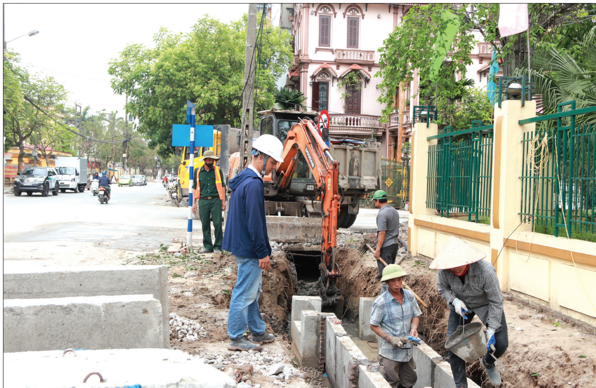
Thi công rãnh dọc thoát nước dự án cải tạo, chỉnh trang vỉa hè phố Trần Hưng Đạo (thành phố Thái Bình).
