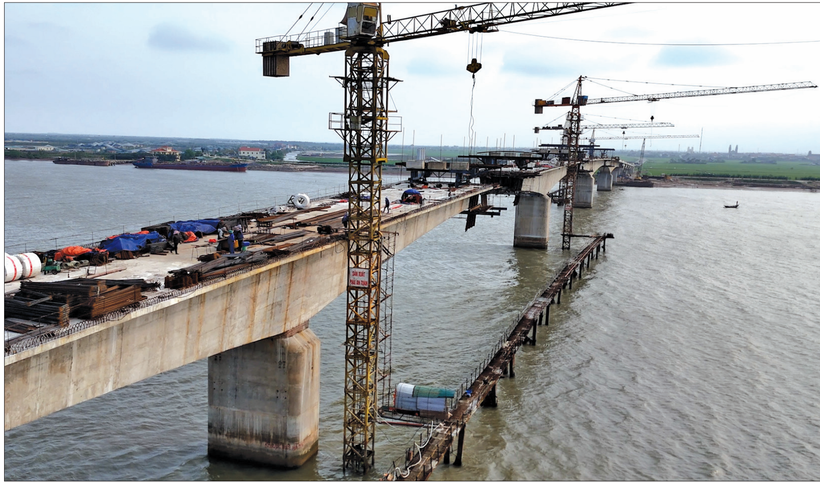
Cầu sông Hồng thuộc dự án tuyến đường bộ ven biển đang dần hoàn thiện.
