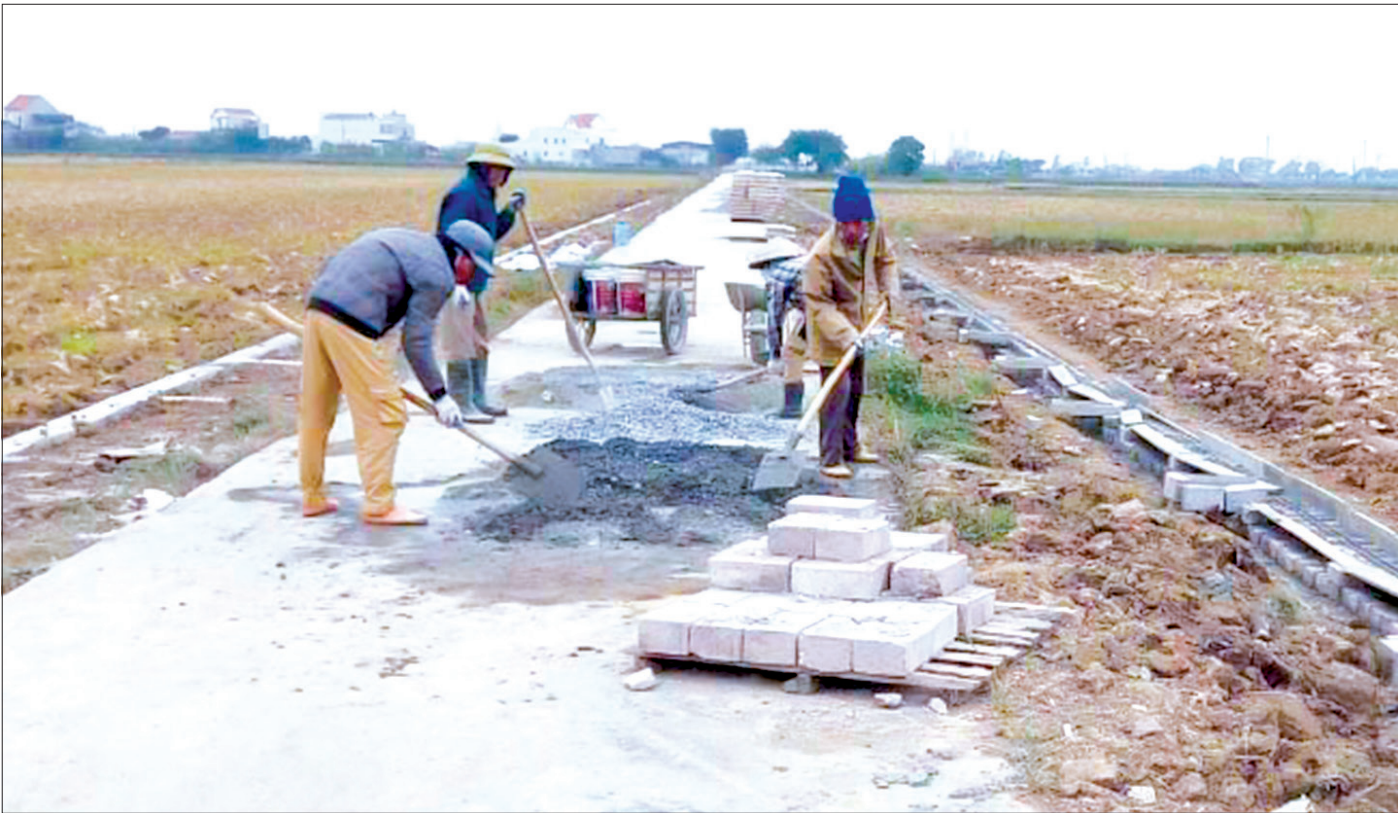
Nhờ dân vận khéo, thôn Hoàn Từ, xã Đông Cường (Đông Hưng) đã huy động được sức dân mở rộng đường vào thôn.
