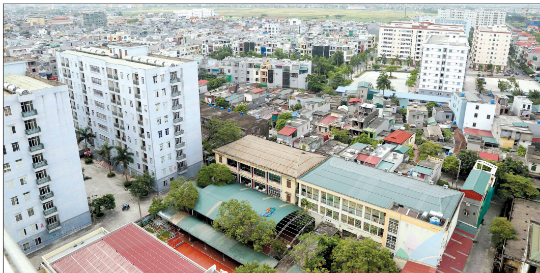
Thành phố Thái Bình.
