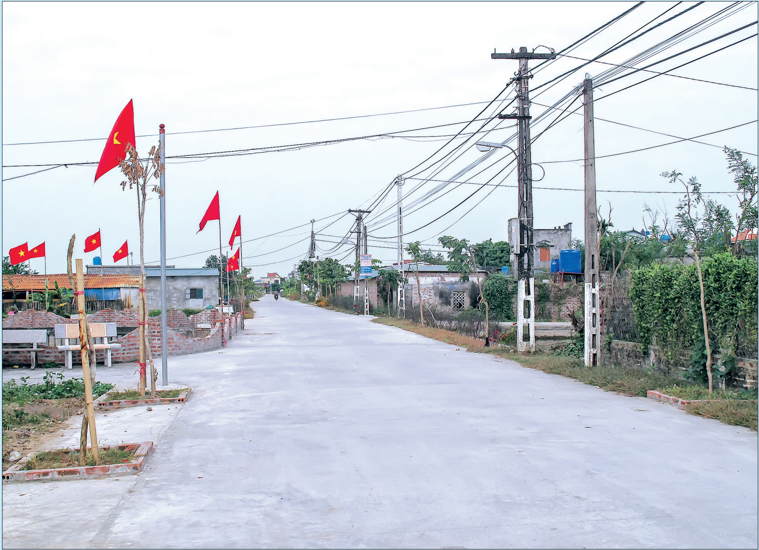
Đường thôn Vĩ Thủy, xã Thái Dương được mở rộng.
