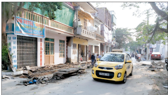
Sửa chữa, nâng cấp đường Phan Bá Vành.
