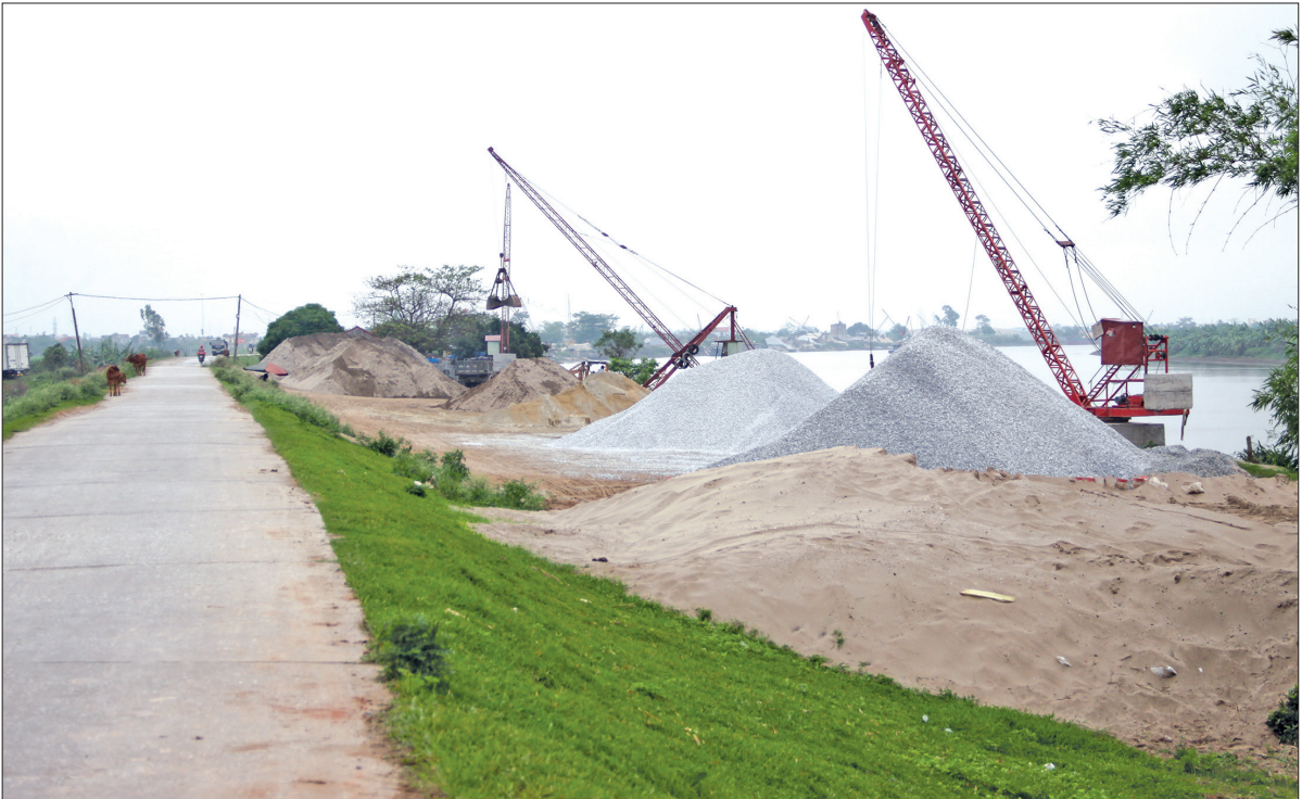
Hàng chục bến bãi vật liệu xây dựng trên tuyến đê tả Trà Lý đoạn qua địa phận huyện Đông Hưng dù đang trong giai đoạn làm hồ sơ xin giấy phép nhưng vẫn ngang nhiên hoạt động.
