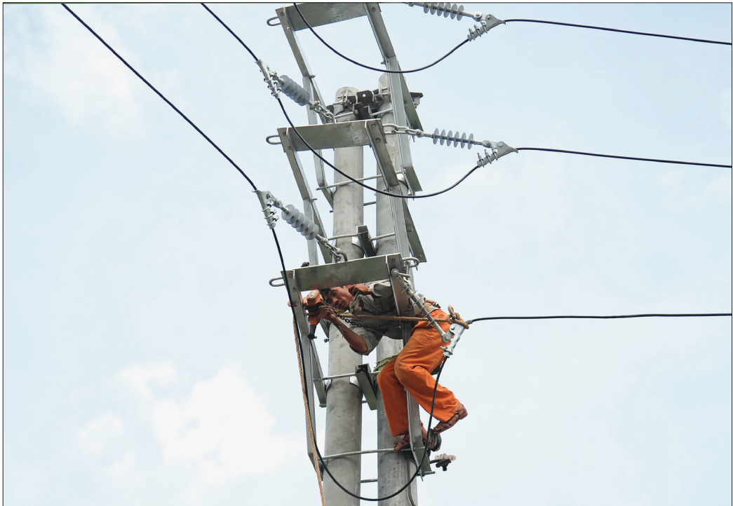
Công nhân Điện lực Kiến Xương sửa chữa, nâng cấp đường điện hạ thế xã Bình Minh.
