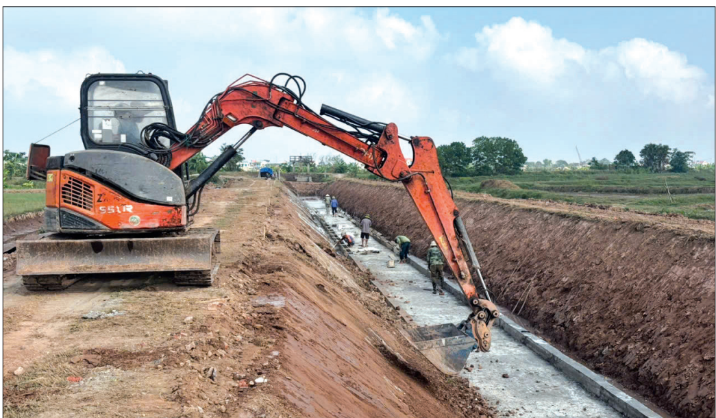
Kiến cố hóa kênh xả tiêu trạm bơm Trà Giang (Kiến Xương).
