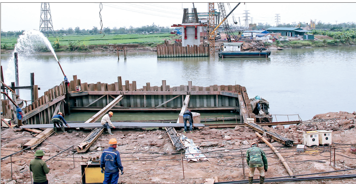
Công trường thi công cầu La Tiến, huyện Hưng Hà.
