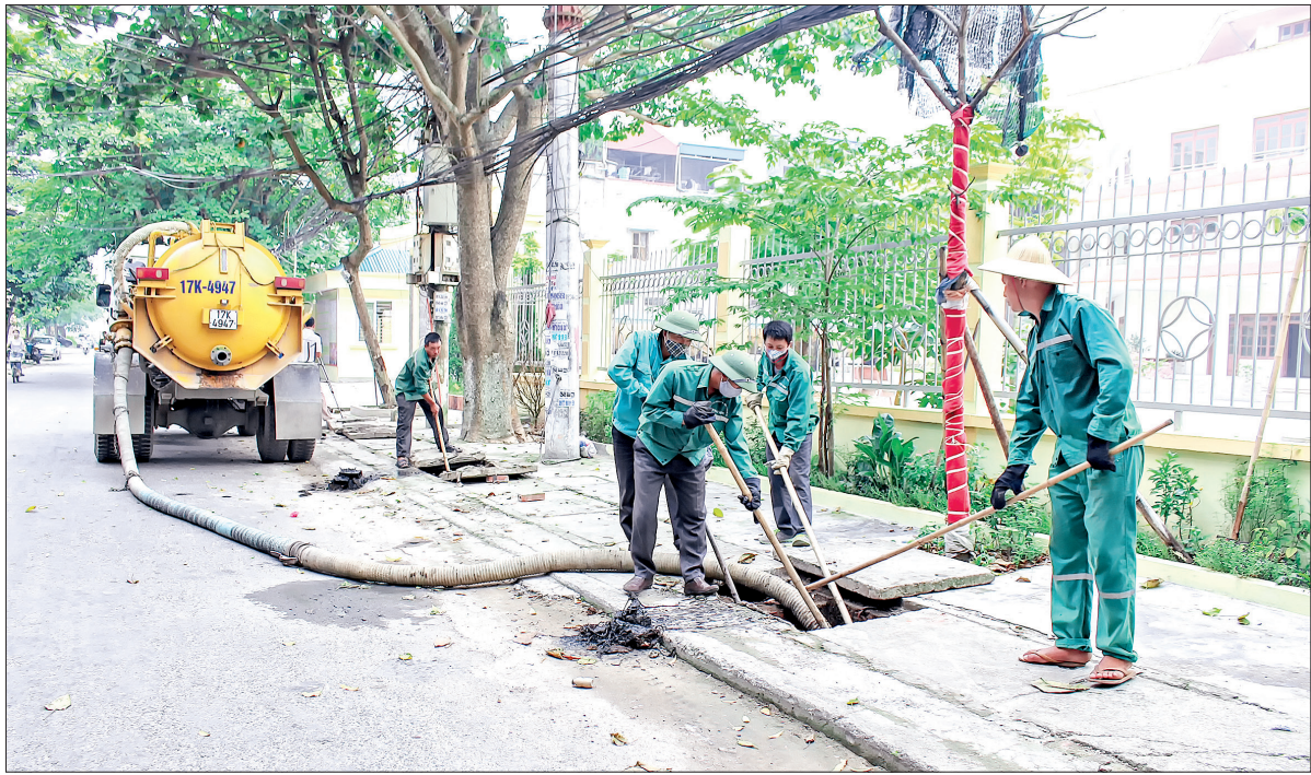
Công nhân Công ty Cổ phần Môi trường và Công trình đô thị Thái Bình nạo vét, tu sửa hệ thống cống thoát nước tại đường Hoàng Công Chất (thành phố Thái Bình).
