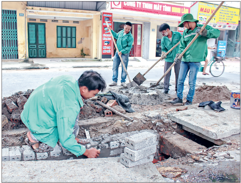
Công nhân Công ty Cổ phần Môi trường và Công trình đô thị Thái Bình nạo vét, tu sửa hệ thống cống thoát nước tại đường Hoàng Công Chất (thành phố Thái Bình).
