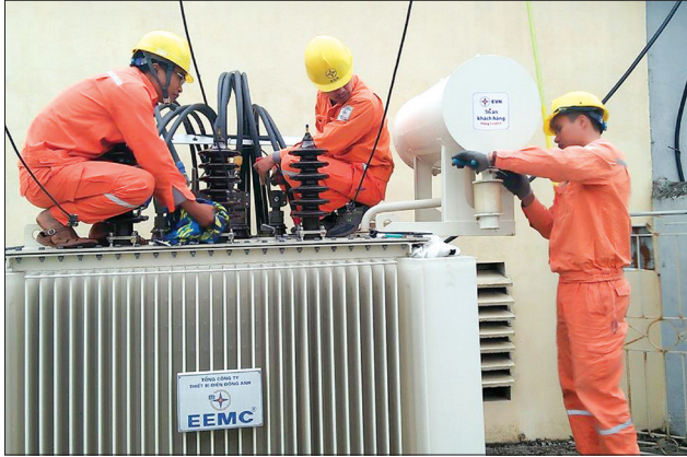
Công nhân Điện lực Hưng Hà tổ chức vệ sinh miễn phí trạm biến áp cho khách hàng.
