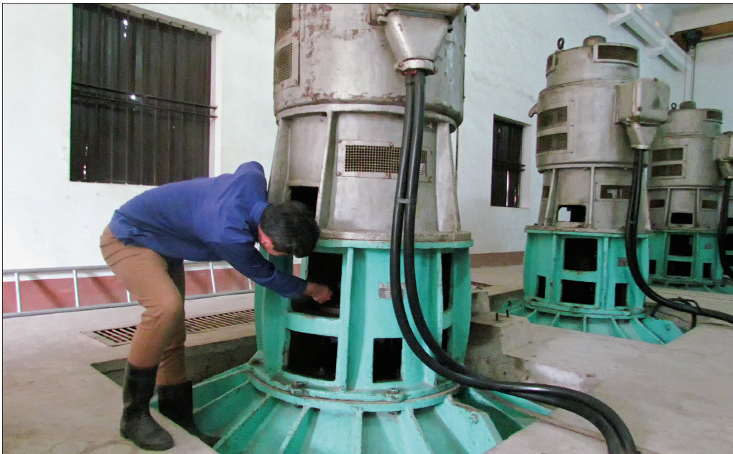
Nhân viên trạm bơm Minh Tân (Hưng Hà) bảo dưỡng máy móc sẵn sàng vận hành chống ngập úng.
