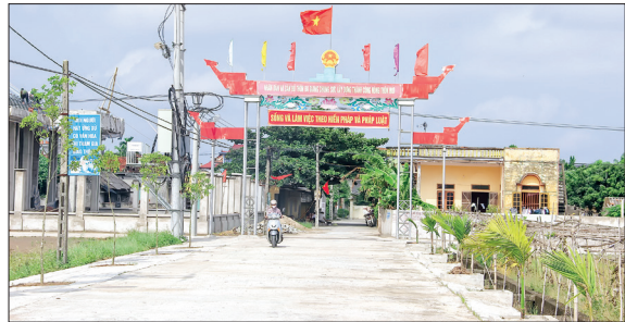
Đường giao thông xã Nguyên Xá (Đông Hưng).
