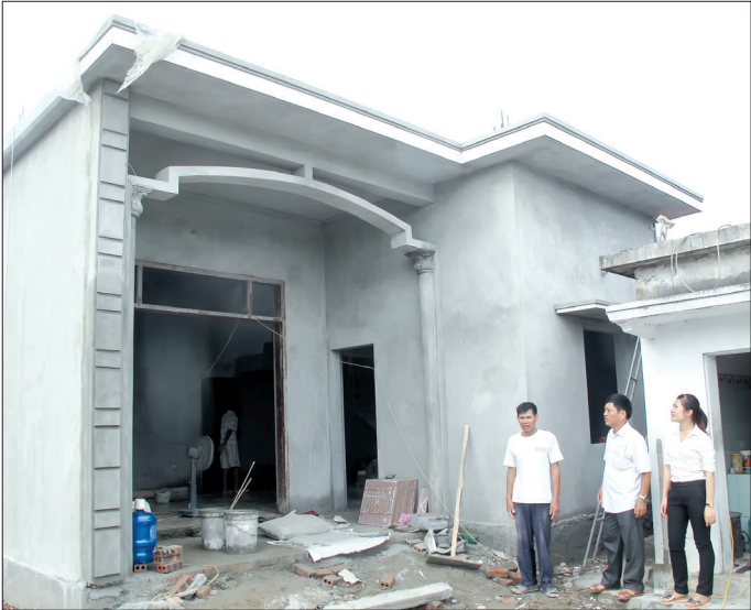
Nhà ở của thương binh Phạm Văn Thao (thôn Tây Thuận, xã Hồng Quỳnh, huyện Thái Thụy) đang được xây dựng.
