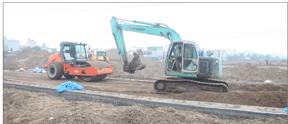
Hiện nay, nhà thầu đã triển khai thi công công việc bóc hữu cơ, san lấp cát và đất trên phần lớn diện tích đất thuộc dự án.
