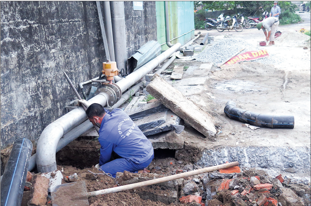
Công ty Cổ phần Bitexco Nam Long thực hiện lắp đặt đường ống dẫn nước thải từ Công ty về trạm xử lý nước thải của Trung tâm Dịch vụ khu công nghiệp sau khi sự việc cá chết xảy ra.
