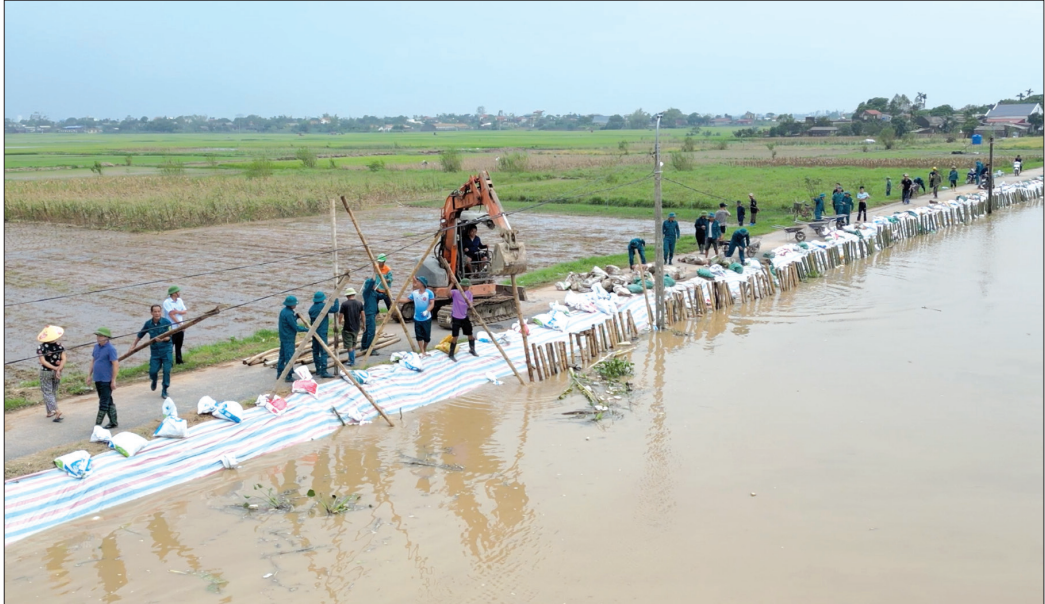
Các lực lượng tham gia gia cố tuyến đê bồi xã Quỳnh Lâm (Quỳnh Phụ).
